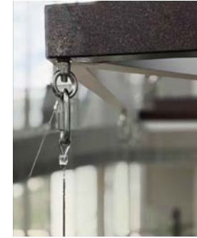
3 天花连接细节图 CEILING CONNECTION DETAIL
